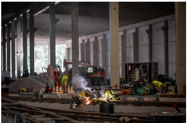
Kuva: Raidetöitä Koskelan varikon työmaalta
