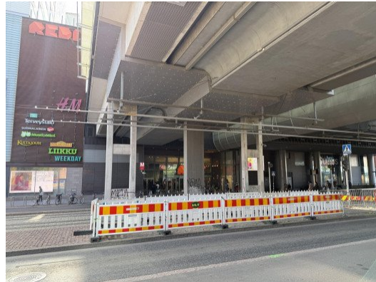
Työmaa-alue Redin edustalla.
