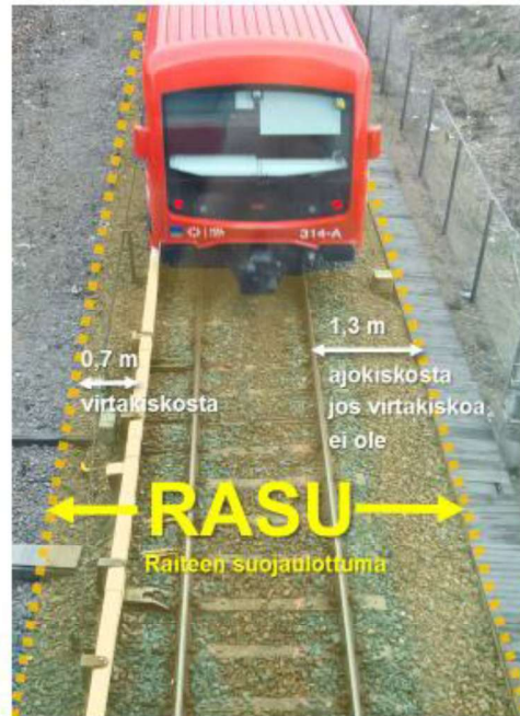
Kuva 7. Raiteen suojauslaittuma eli RASU
