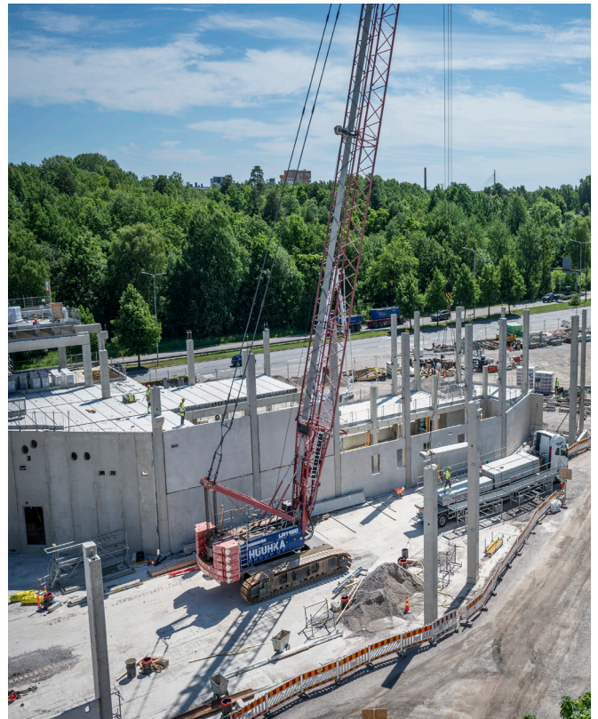
Yleiskuvaa Koskelan varikon työmaalta
