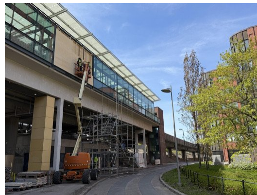
Työmaanaikaisen hätäpoistumistornin rakentaminen käynnissä.
