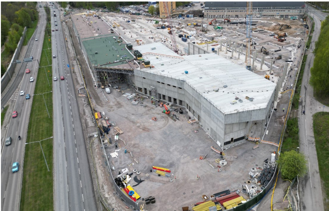
Yleiskuvaa Koskelan varikon työmaalta
