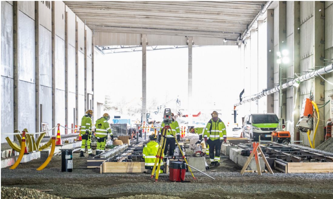
Ratarakentamista kuvassa. Kuvaaja Sami Perttilä.
