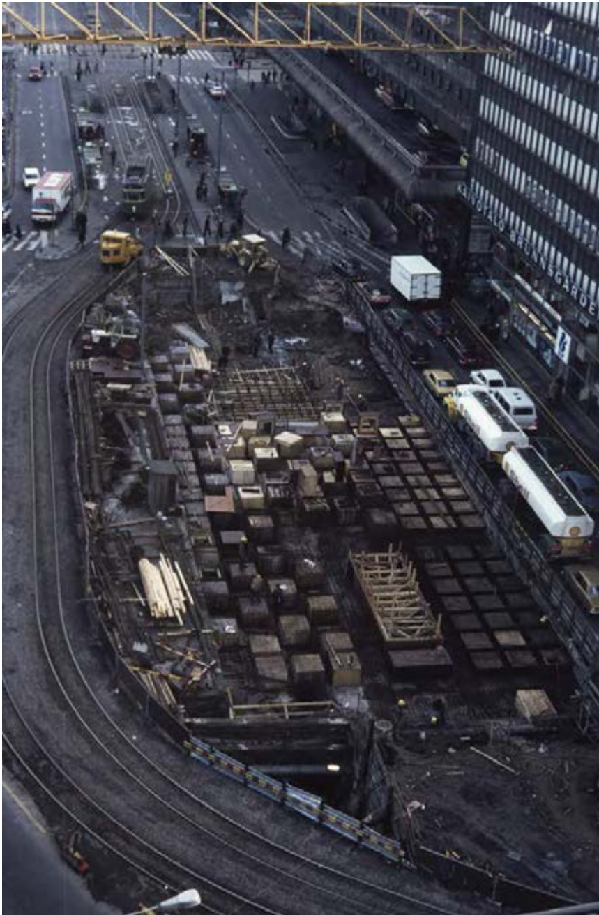
← Kennobetonilaatan valutöiden valmistelua Kaivokadulla vuonna 1978. Osmo Aittapelto, 1978, HKM.
