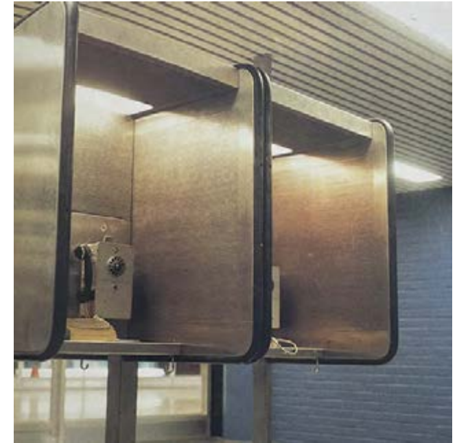
↑ Puhelinsuojat valmistettiin ruostumattomasta teräksestä, ja niiden nurkat pyöristettiin. Muotoilun ja materiaalivalintojen keskiössä olivat käytännöllisyys ja selkeys. Kuva julkaistu teoksessa Helsingin Kaupungin Metrotoimisto, Helsingin metro 1982.
