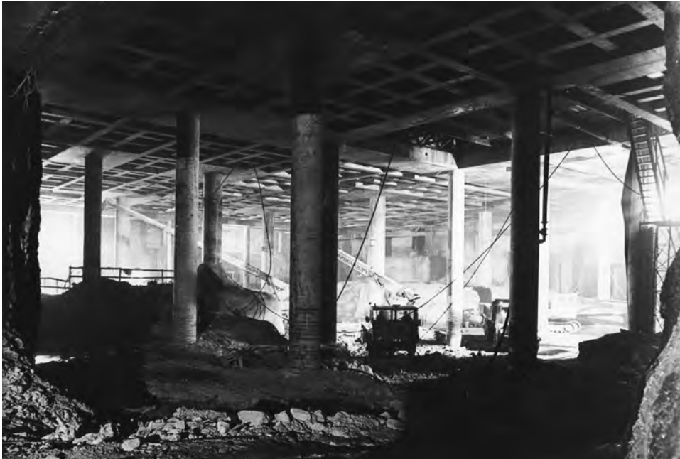
↑ Rautatien metroaseman lippuhallin louhintatyöt. Kuva Allan Pyykkö nuorempi, 1970-luku, HKM.
