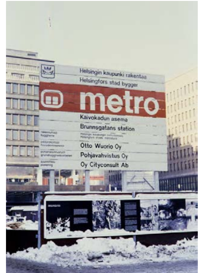
↑ Metroaseman rakennustyömaataulussa näkyvät pääurakoitsijan, pohjarakentajan ja suunnittelutoimiston nimet. Kuva Osmo Aittapelto, 1979, HKM.
