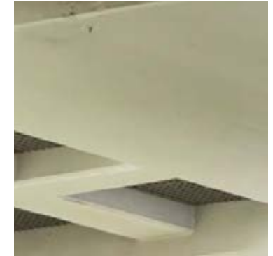
Vaaleaksi maalattu teräsbetoni
