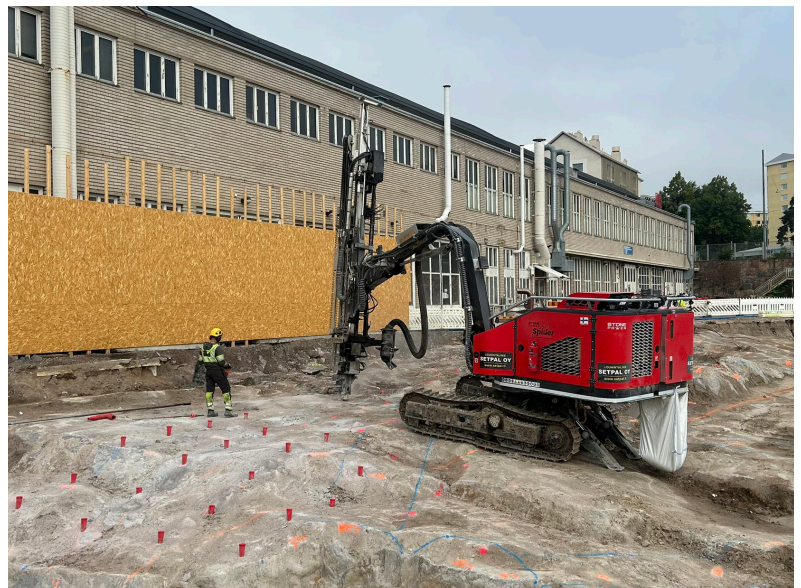
Kuva: Rakolinjan porausta louhintaa varten.
