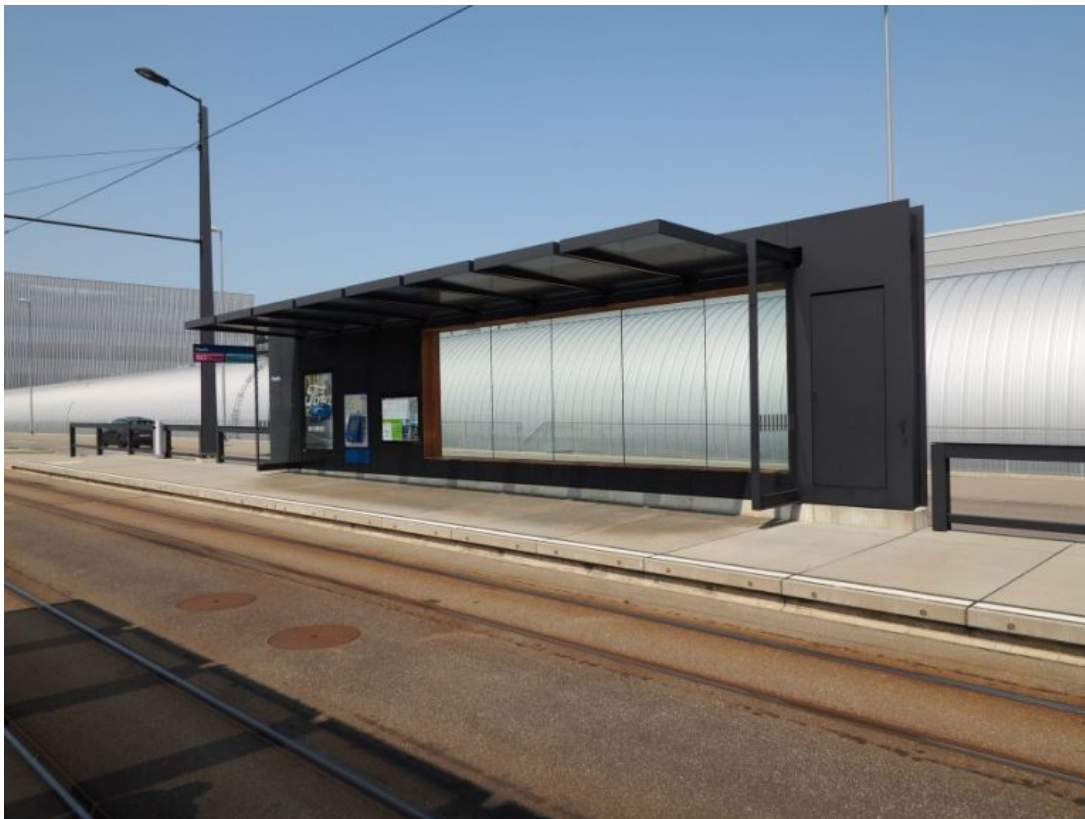
Kuva 12. Pitkä pysäkkikatos. Zürichissä, Glattalbahn. (Noora Salonen)
