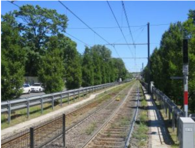
Kuva 19. Raitiotien vahva rajaaminen, rautatiemäinen osuus. Köln, Riehler Strasse (Lauri Kangas).
