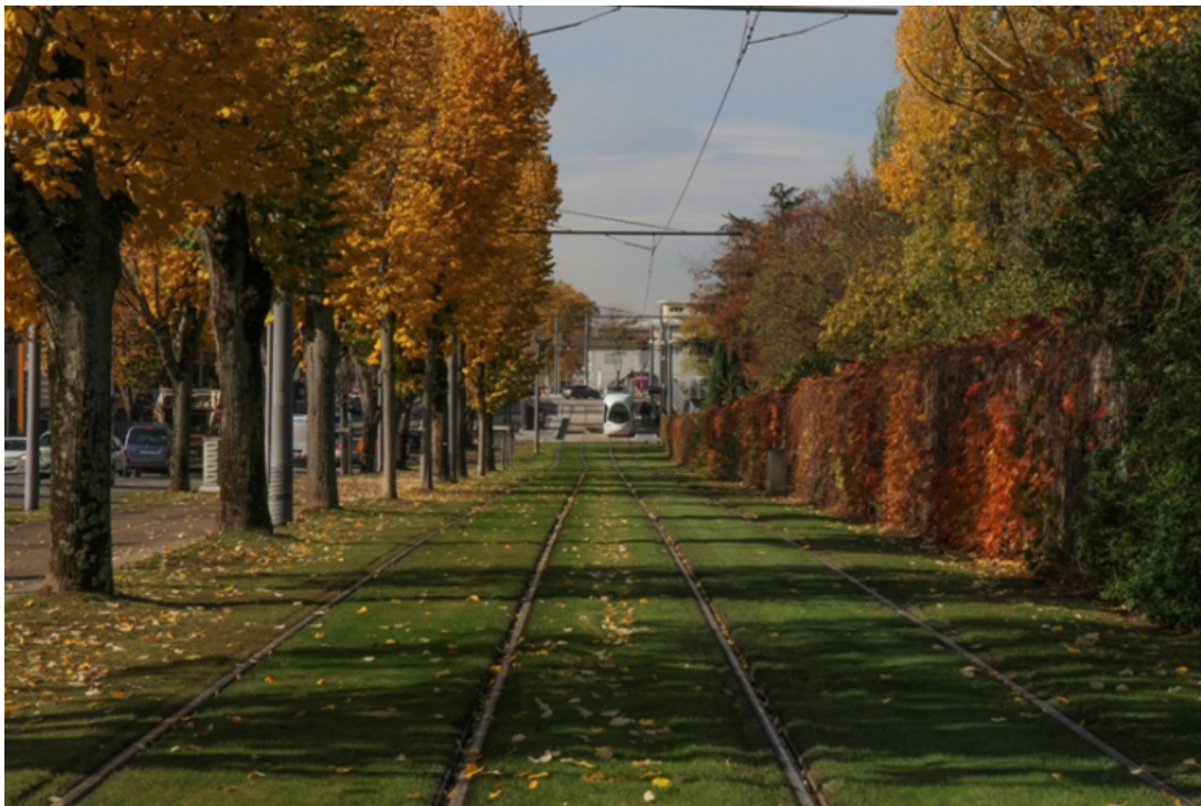
Kuva 16. Raitiotiealue rajattu puuistutuksilla ja köynnösten peittämällä aidalla. Lyon (Davy Beilinson).
