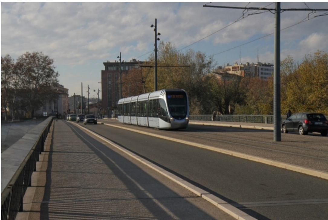
Kuva 14. Raitiotie korotetun reunatuen takana omalla kaistallaan, pintamateriaali betoni, ajoradoilla asfaltti. Toulouse (Davy Beilinson).
