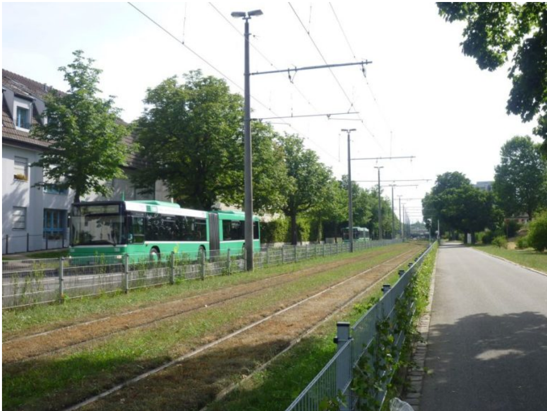
Kuva 18. Aitaamalla mahdollistetaan raitiotien korkea nopeus turvallisesti jalankulkuväylän vieressä. Basel, Riehenstrasse (Lauri Kangas).
