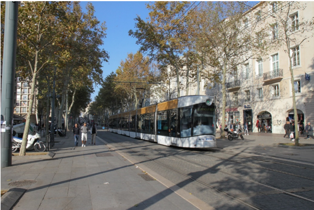
Kuva 12. Esimerkkikuva radan erottelusta kivimateriaalin, upotetun reunatuen ja ladonnan muutoksilla muuhun kaupunkiympäristöön sovittaen. Marseille tram (Davy Beilinson).
