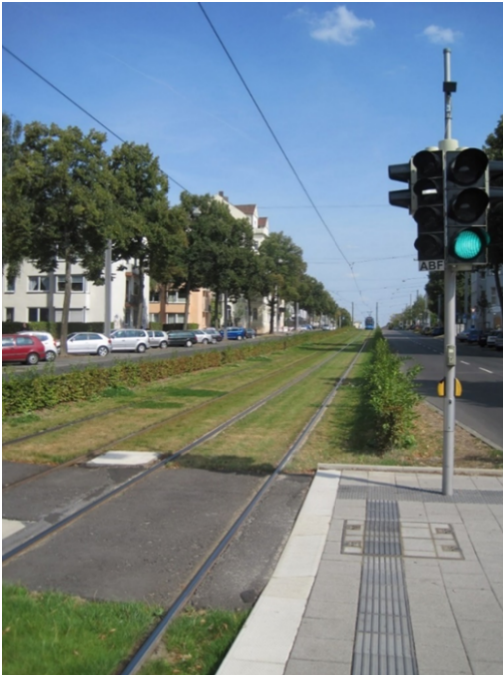
Kuva 15. Nurmiraiteen rajaaminen pensasaidalla. Raitiotien pintamateriaali eroaa muista kadun pintamateriaalista. Kassel (Minna Pöyhölä).
